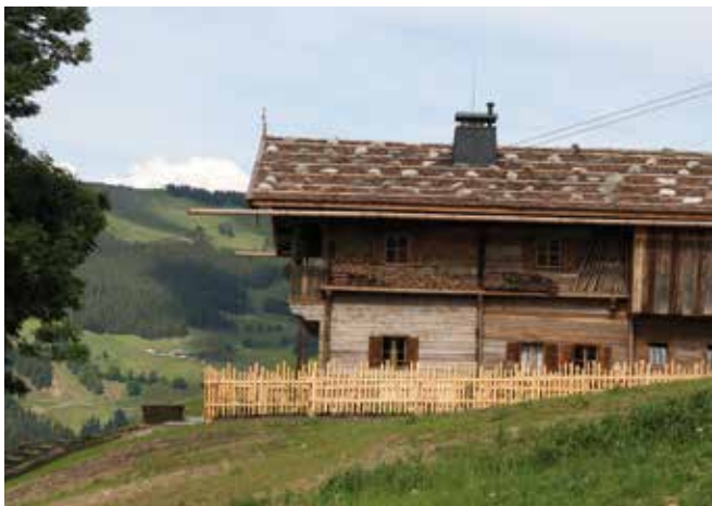
Abbildung 13: Passend zu Schindeldächern unterstreichen Dachrinnen aus Holz den traditionellen Charakter von Almhütten und Bauernhäusern. (© Gerhard Mader)
