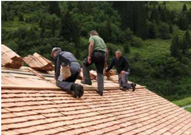
Abbildung 1: Schindeldächer sind aufgrund ihrer Beständigkeit und Ursprünglichkeit nach wie vor typisch für Almhütten. (© Gerhard Mader)
